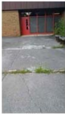
GLE Replace concrete sidewalks)
